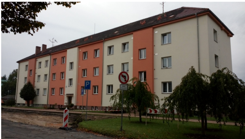
rok 2014 (rekonstrukce 12 ks. balkonů, Na Sídlišti v Libáni)
