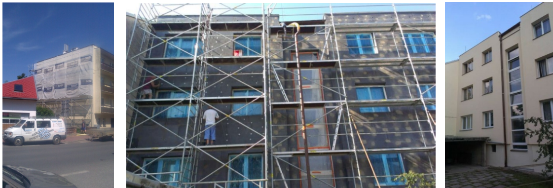
rok 2013 (oprava, nátěr fasády a zhotovení firemního loga Roztoky u Jilemnice)
