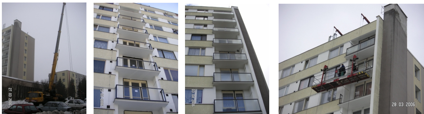
rok 2006 (SBDO, kompletní rekonstrukce 14 ks. balkonů)
