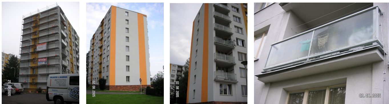
rok 2005 (Bytové družstvo Mnichovo Hradiště) zateplení části panel. domu, rekonstrukce zábradlí
