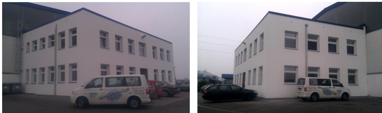
rok 2011 (zasklení 9 ks lodí v Nové Pace)
